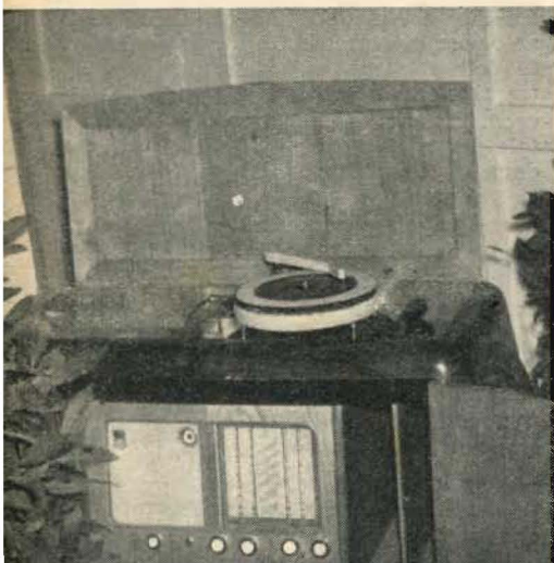
Il « Bondo »: adattatore per la riproduzione dei dischi a microsolco. Esso permette di ottenere sia una rotazione del piatto di 45 giri al primo, sia di 33 giri e 1/3 al primo, disponendo di un complesso giradischi di tipo comune a 78 giri.
